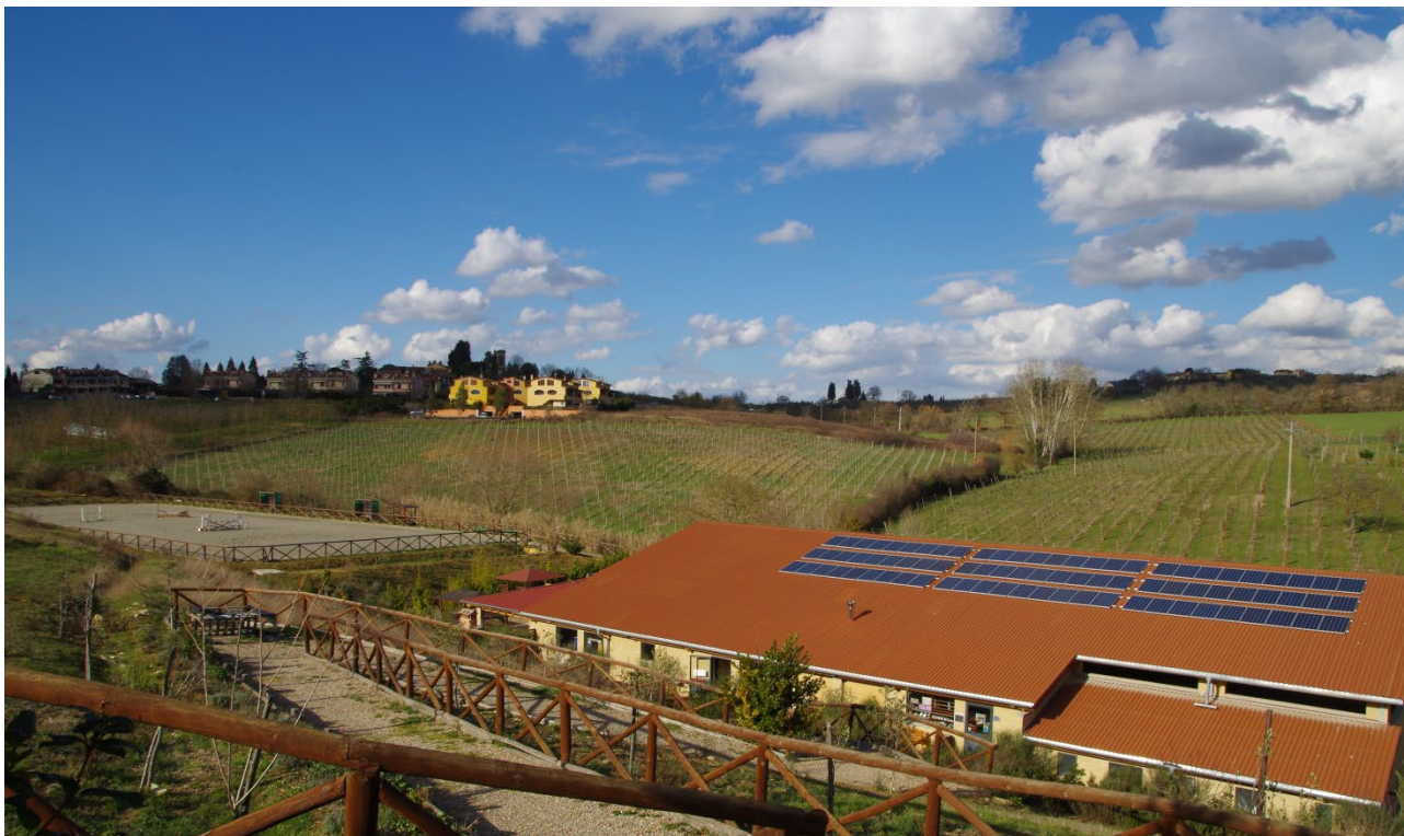
Maneggio coperto e scoperto della Polisportiva Blu
